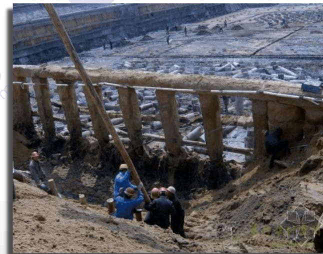
4. 桩间土流失孔洞 深度超过桩径 。
