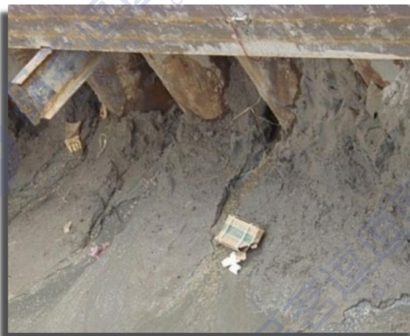
2. 基坑侧壁出现 大量漏水、流土 ；
