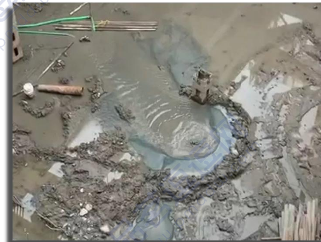
3. 基坑底部出现 管涌 ；
