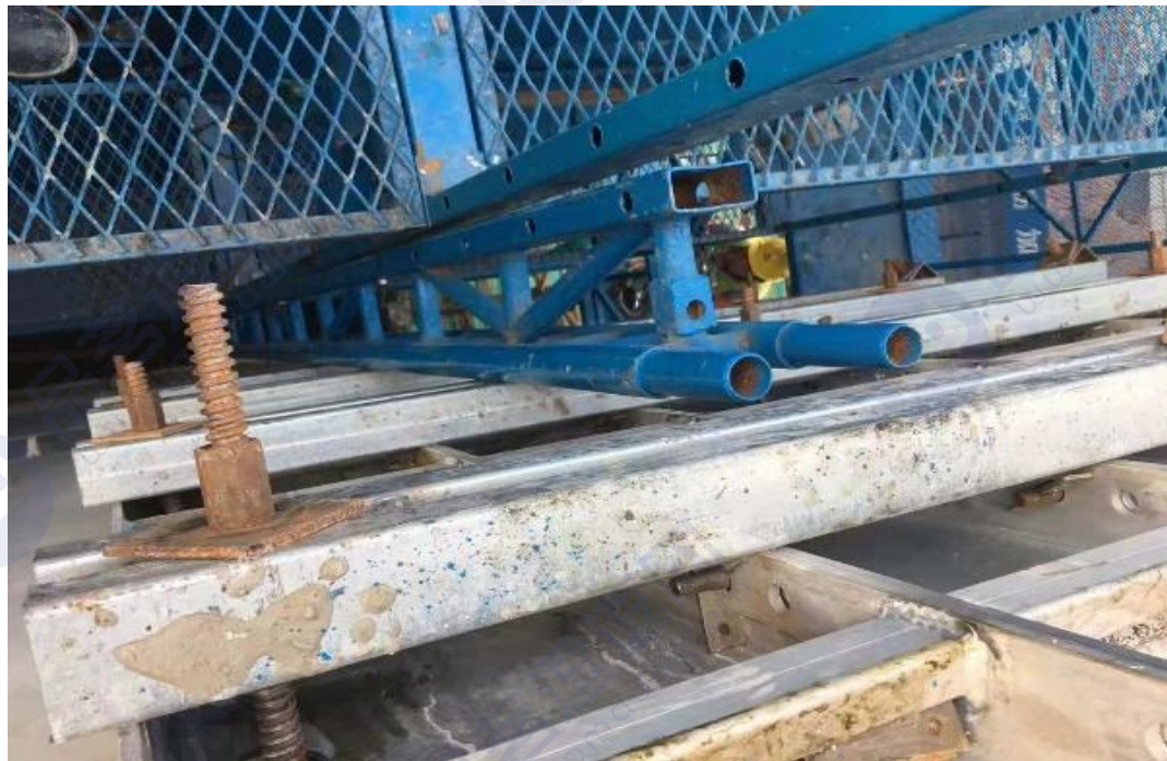
螺杆与爬架导轨冲突
