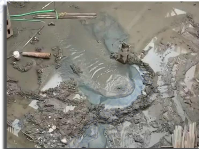
3. 基坑底部出现 管涌 ；
