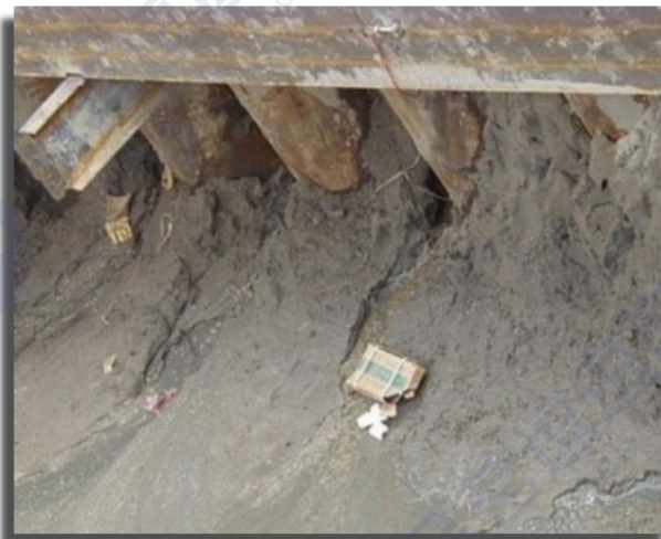
2. 基坑侧壁出现 大量漏水、流土 ；
