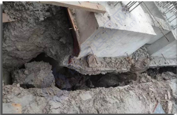
1. 支护结构或周边建筑物变形值超过 设计变形控制值 ；
