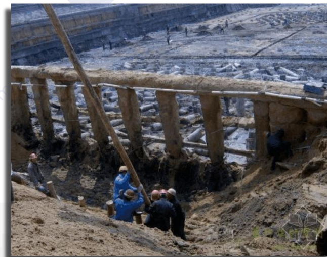
4. 桩间土流失孔洞 深度超过桩径 。
