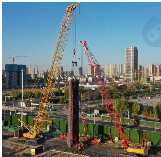
地下连续墙共计140幅，钢筋笼要求整体制作成型，分两段吊装，分段位置采用直螺纹套筒连接。
