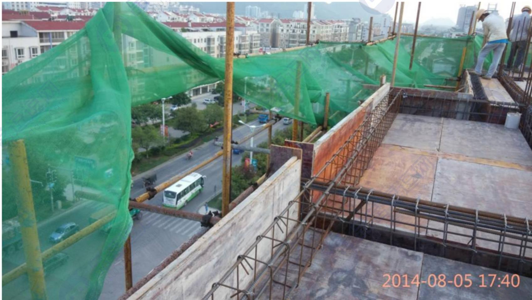
8.2.2 密目式安全立网搭设时每个开眼环扣应穿入系绳，系绳应绑扎在支撑架上，间距不得大于450mm。相邻密目网间应紧密结合或重叠。
