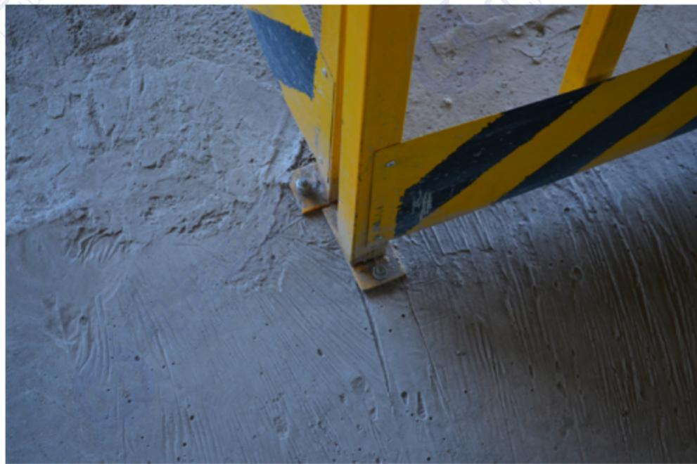
4.3.4 栏杆立杆和横杆的设置、固定及连接，应确保防护栏杆在上下横杆和立杆任何处，均能承受任何方向的最小1kN外力作用，当栏杆所处位置有发生人群拥挤、车辆冲击和物件碰撞等可能时，应加大横杆截面或加密立杆间距。
