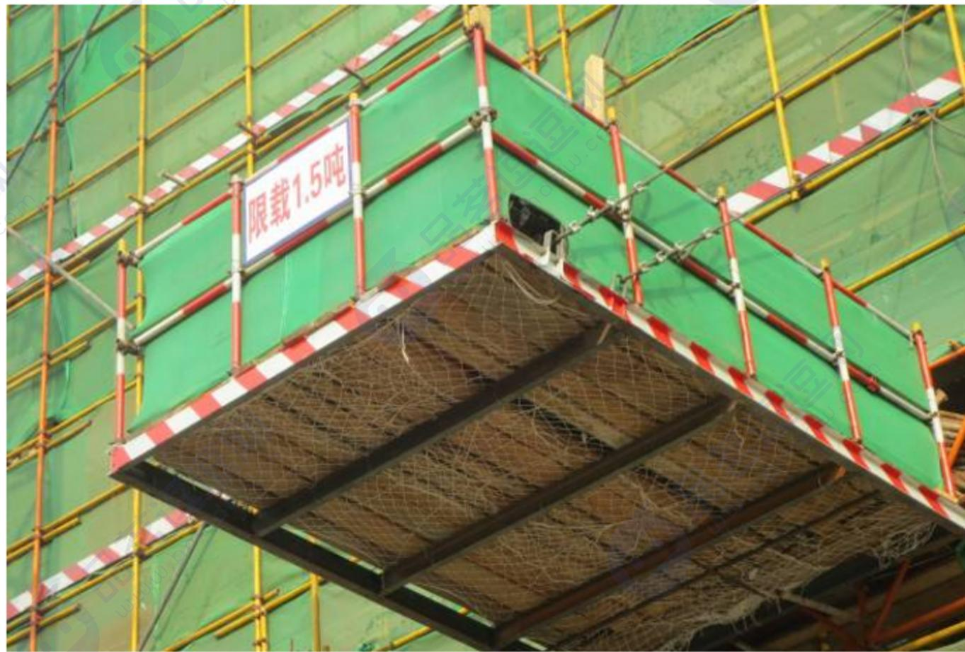
6.4.4 采用支承方式的悬挑式操作平台，应在钢平台的下方设置不少于两道的斜撑，斜撑的一端应支承在钢平台主结构钢梁下，另一端支承在建筑物主体结构。
